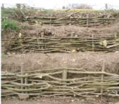
Un fascinage dans les regles de l'art
